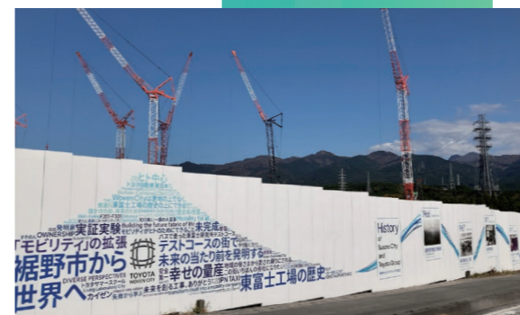
工事現場の仮囲いに描いたメッセージ
