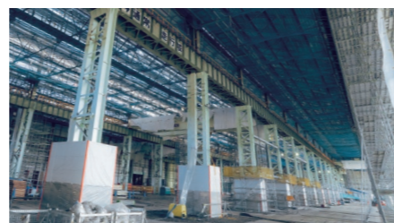
リノベーション中のプレス建屋内部
